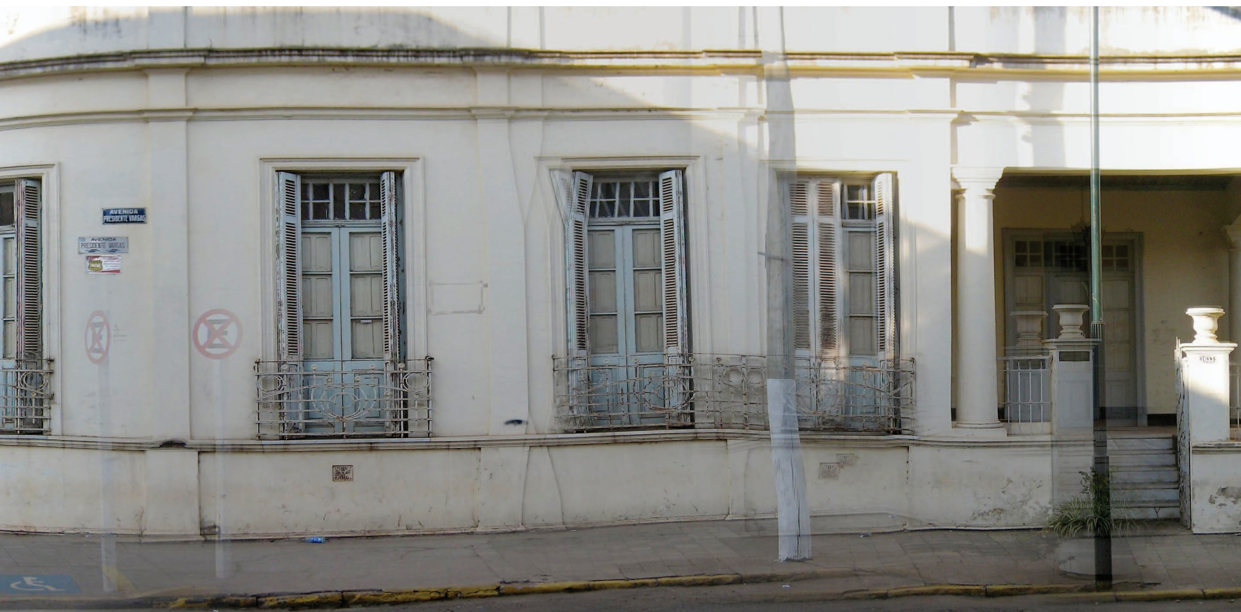
Fachada da residência antes do restauro
