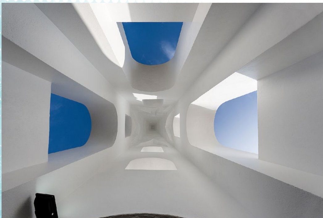
Vista interna da torre da Igreja São Domingos, Torres.
